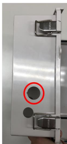
プラボックス側面の穴に電源ケーブルの端を通す
