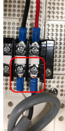
端子台へ接続する
